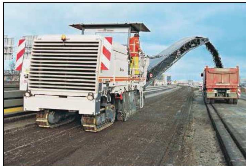
Slika 2.15: Pridobivanje asfaltnega rezkanca z rezkarjem
